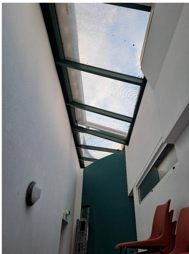
Photo couloir arrière vers salle Comité Directeur
