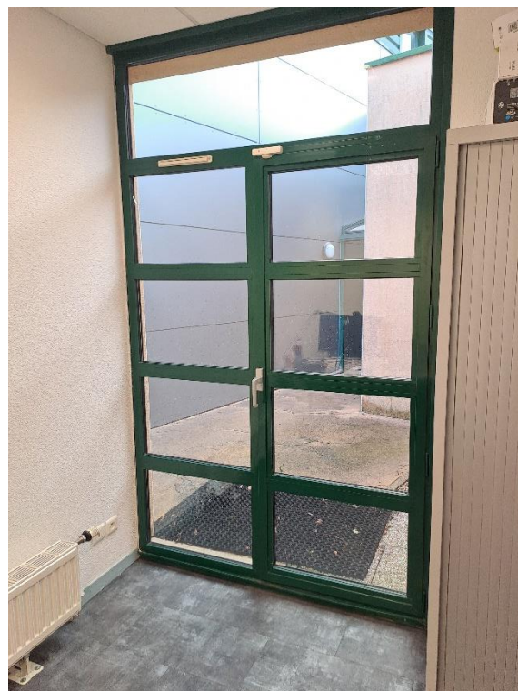
Photo intérieure porte bureau du Directeur
